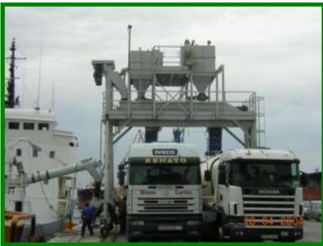
перегрузка цемента с баржи на фуры
