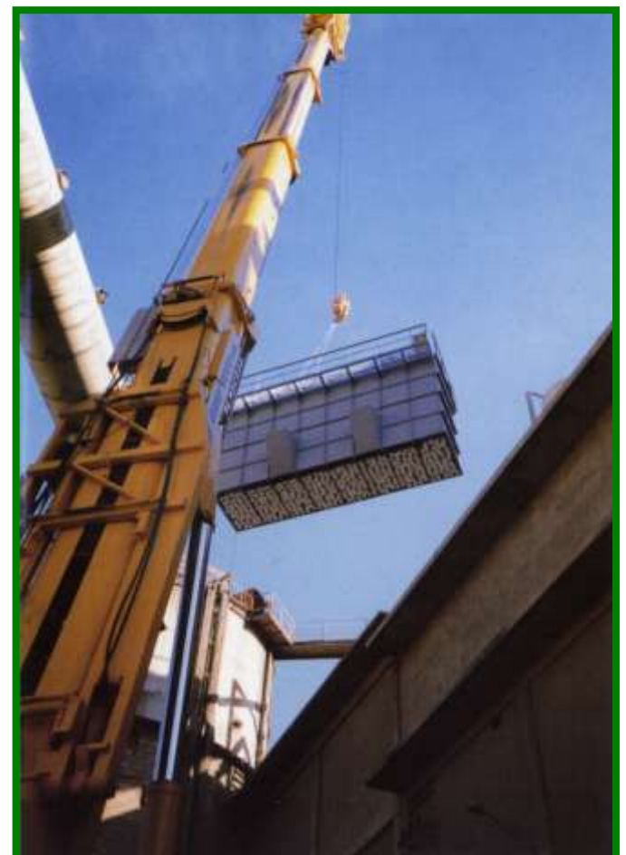
подъем груза при монтаже
